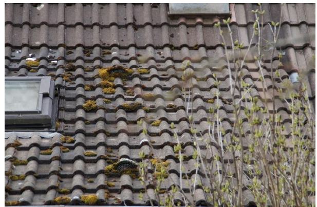
Foto 13: Dacheindeckung Nordseite (Blick nach Süden)
