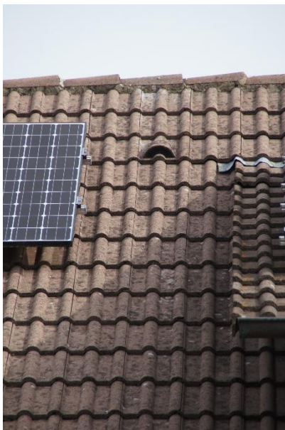
Foto 12 Dacheindeckung Südseite (Blick nach Norden)
