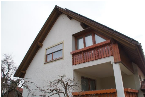
Foto 10 Wohngebäude – westliche Giebelseite (Blick nach Nordosten)
