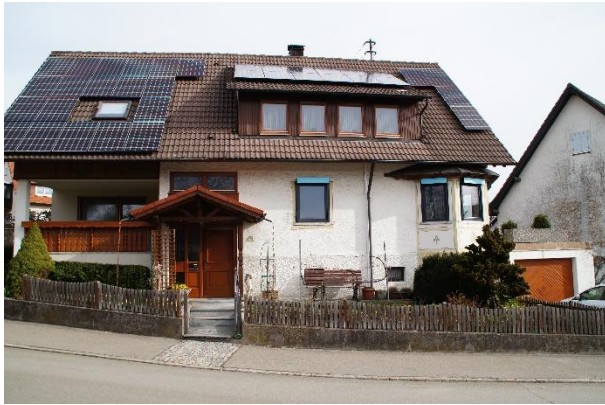
Foto 1: Wohngebäude und Garage (Blick nach Norden)
