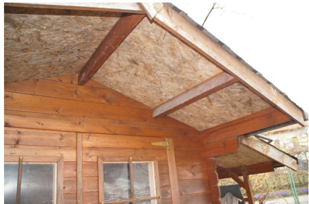
Foto 17: Geräteschuppen – Dachunterseite (Blick nach Nordwesten)
