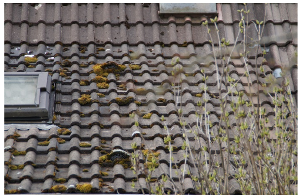
Foto 13: Dacheindeckung Nordseite (Blick nach Süden)
