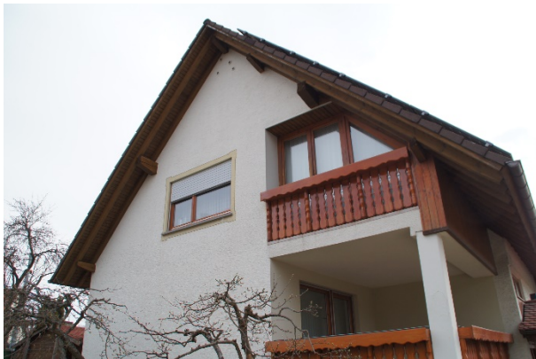
Foto 10 Wohngebäude – westliche Giebelseite (Blick nach Nordosten)
