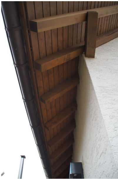
Foto 14 Detail Traufe Nordseite (Blick nach Osten)
