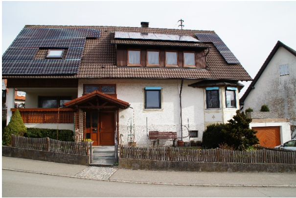
Foto 1: Wohngebäude und Garage (Blick nach Norden)
