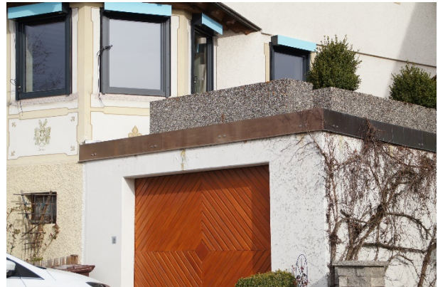
Foto 9: Garage (Blick nach Nordwesten)
