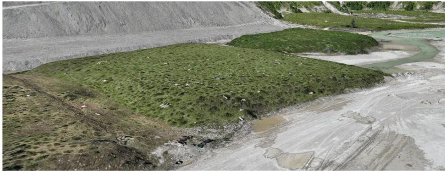
Abb. 7: Beispiel einer Bodenmiete zur Zwischenlagerung von Mutterboden von der Plettenberg-Hochfläche (Bild: Fa. Holcim).
