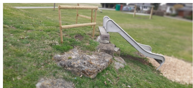
Abb. 13: Ansichten auf die wenige m 2 umfassende Trockenmauer, welche auf dem Spielplatz im Bereich der Rutsche errichtet wurde.
