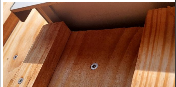
Standort: Südlich Lagerhalle / Sicht auf eines der Fensterbretter (Foto: J. Mauch, 19.03.2024)
