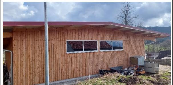
Standort: Nordwestlich Lagerhalle / Blickrichtung: Osten, Sicht auf Westseite der Lagerhalle (Foto: J. Mauch, 19.03.2024)
