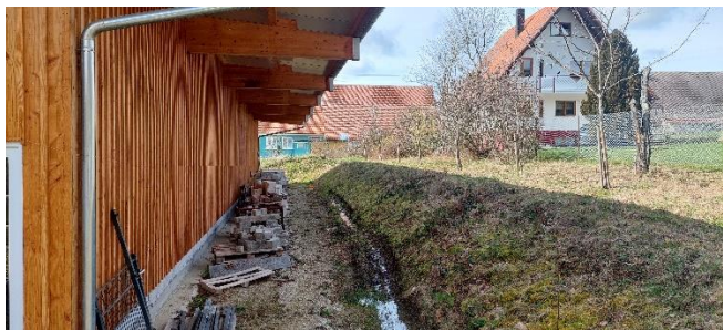
Standort: Nordöstlich Lagerhalle / Blickrichtung: Westen, Sicht auf die Nordseite der Lagerhalle und junger Baumreihe (Foto: J. Mauch, 19.03.2024)
