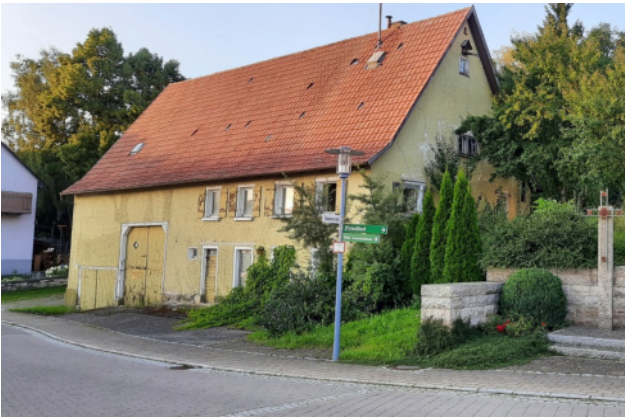
Abb. 17: Unbewohntes Gebäude außerhalb des Geltungsbereichs in der Oberen Gasse 13, welches von Fledermäusen als Quartier genutzt wurde
