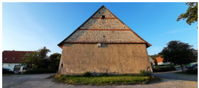
Abb. 12: Giebelansicht der Scheune
